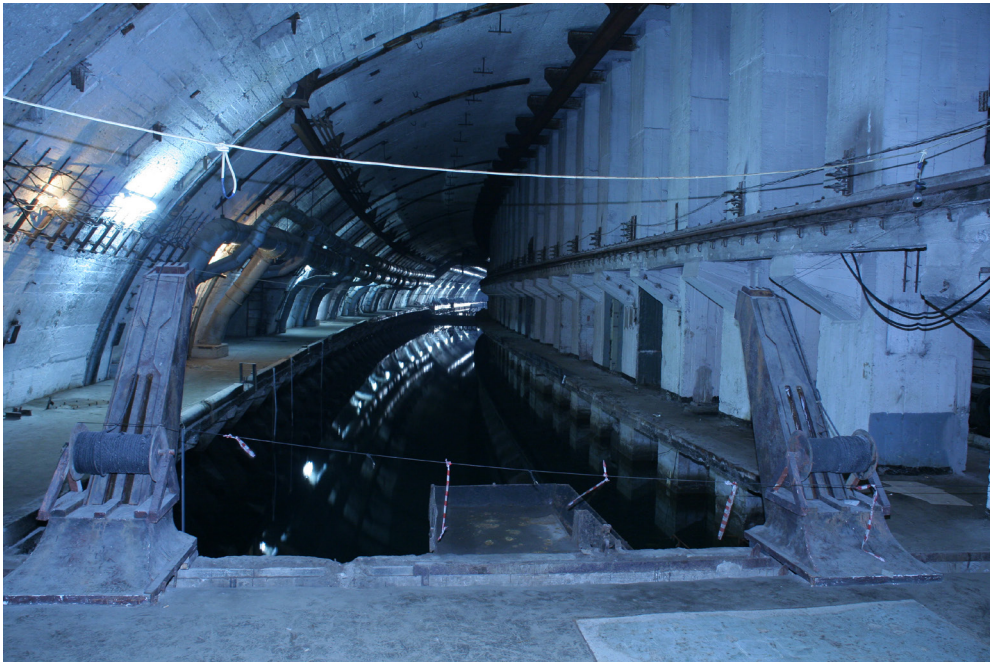
Фото 7. Сухий док, призначений для проведення ремонту підводних човнів (фото з архіву НВІМУ)
