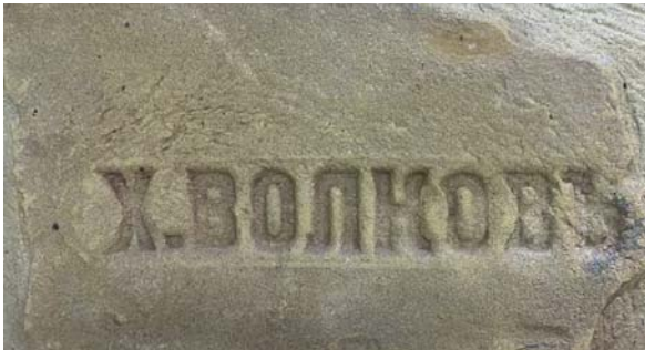
Рис. 5. Цегла, виготовлена на заводі Хаїма Волкова
